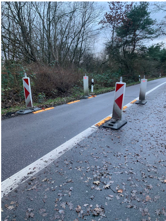
Abbildung 12: Breitenbegrenzung vor der Brücke.
