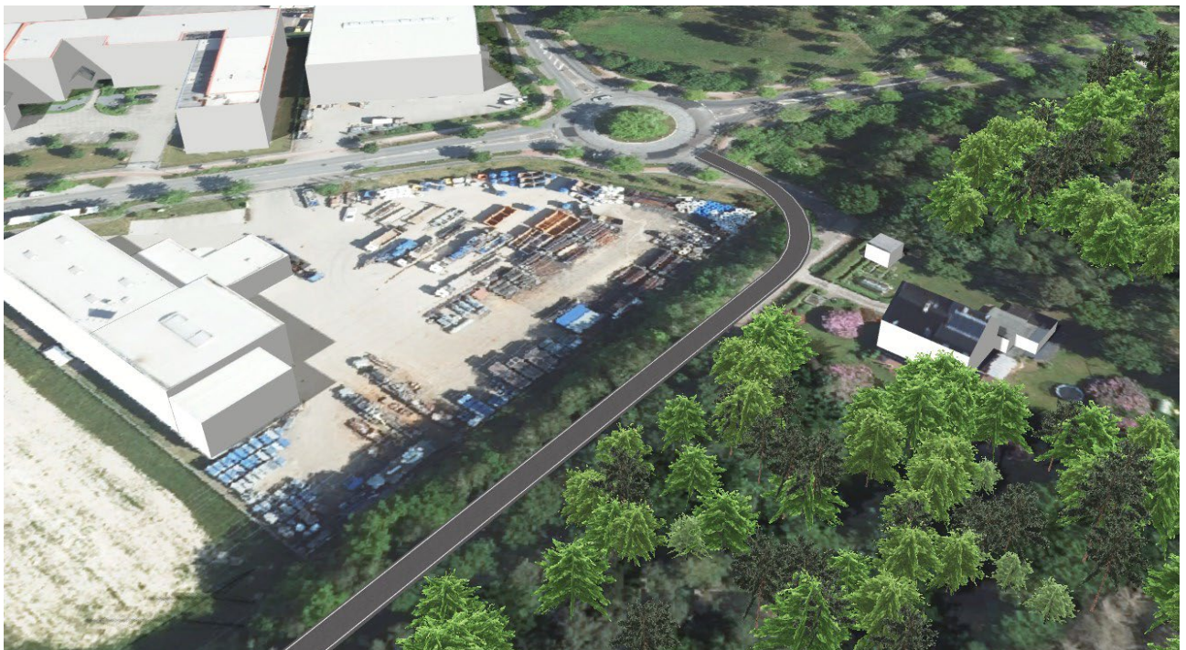
Abbildung 44: Visualisierung des Ausbaus des Schalmoorweges.
