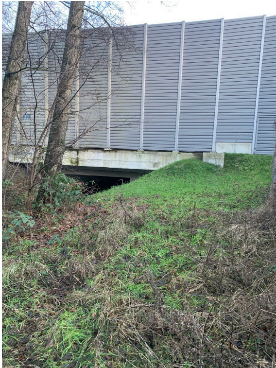
Abbildung 3: Lärmschutzwand im Bereich des Durchlasses.
