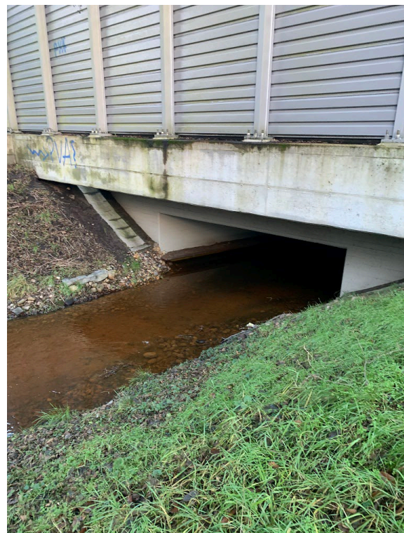
Abbildung 2: Durchlass der Gronau an der BAB A7.
