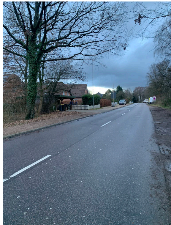
Abbildung 13: Angebauter Sanierungsabschnitt der Ulzburger Landstraße östlich der BAB A7.
