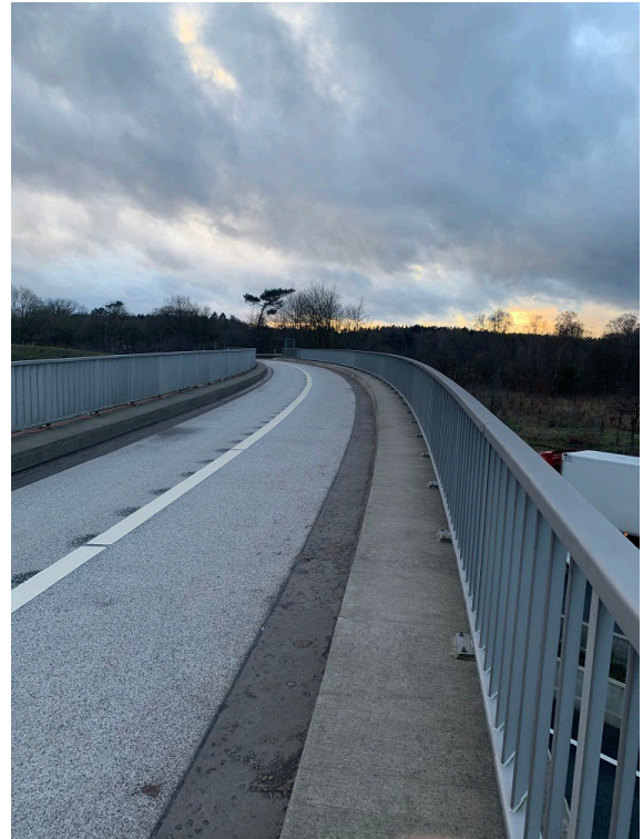
Abbildung 8: Fahrbahn der Brücke über die BAB A7
