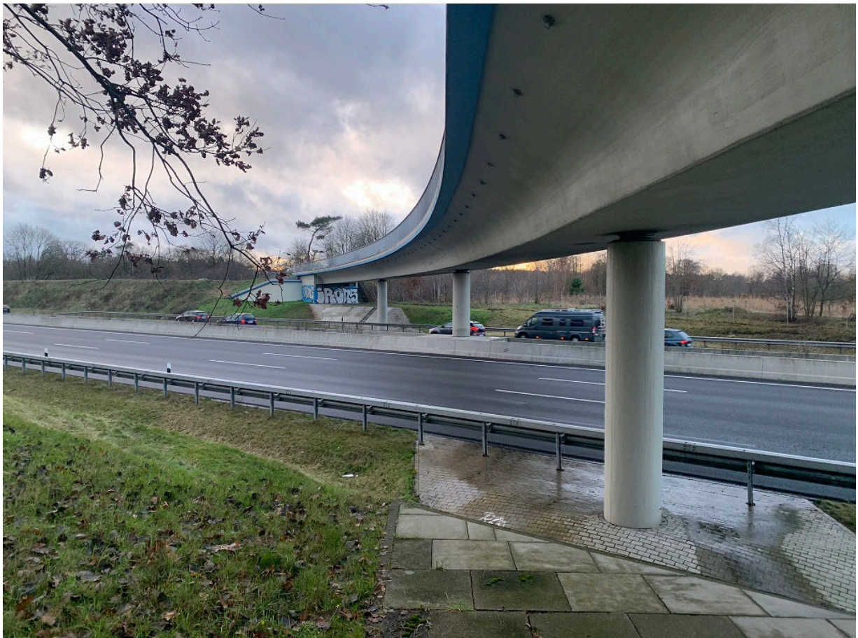
Abbildung 9: Tragkonstruktion des Brückenbauwerkes.
