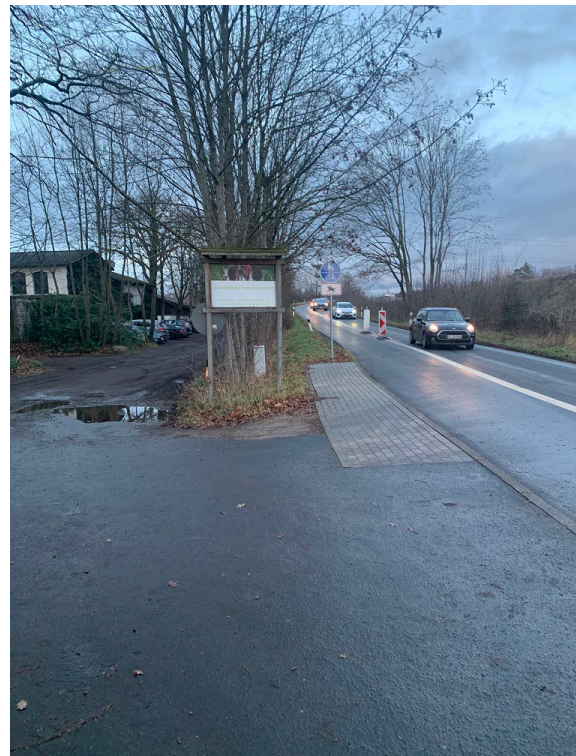
Abbildung 6: Rampe zum Brückenbauwerk über die BAB A7.
